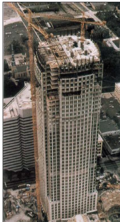
Fig. 2 - Edificio di grande altezza.
