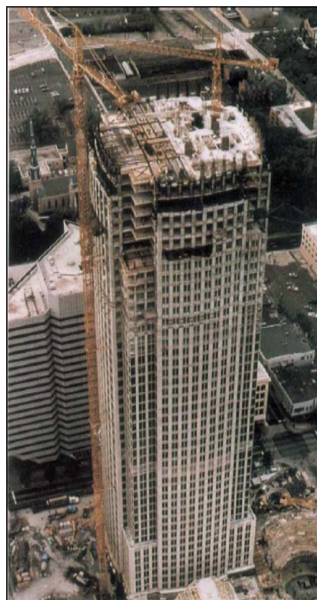
Fig. 2 - Edificio di grande altezza
